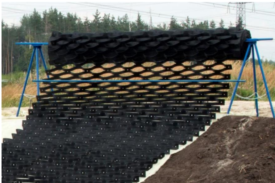
Рисунок 5. Укладка «ГЕОСТЕП®» при помощи козел
