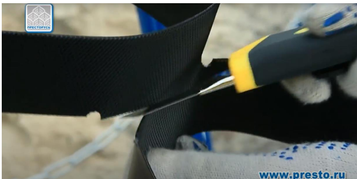
Рисунок 6. Обрезка ячеек «ГЕОСТЕП®»
